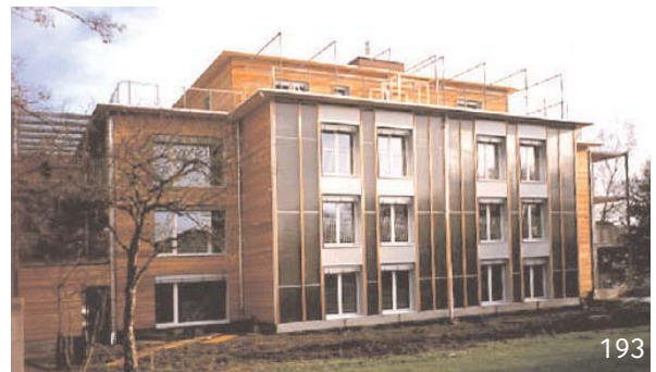
Trombe Wall, Ryckenburg
